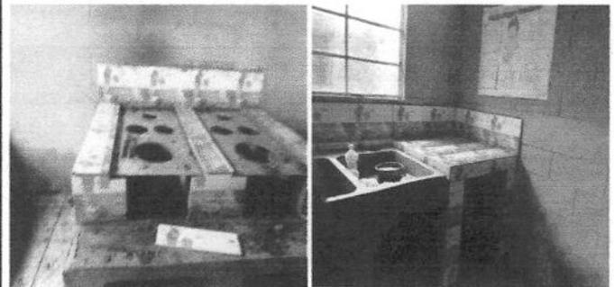
Foto 6: En las fotos se observaba la terminación de plancha de metal de 3 homillas que son utilizadas para la cocina escolar.
