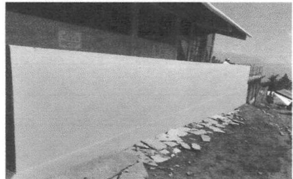
Foto 4: En la Foto que observamos la terminación de muro perimetral de block, enfrente de las aulas del primer modulo.
